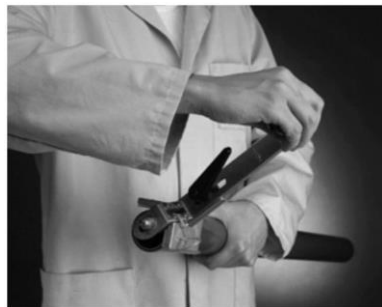
Снятие фаски с торцов труб
