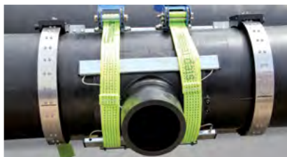
Гибкое соединение с хомутом: сверление под давлением в процессе эксплуатации
